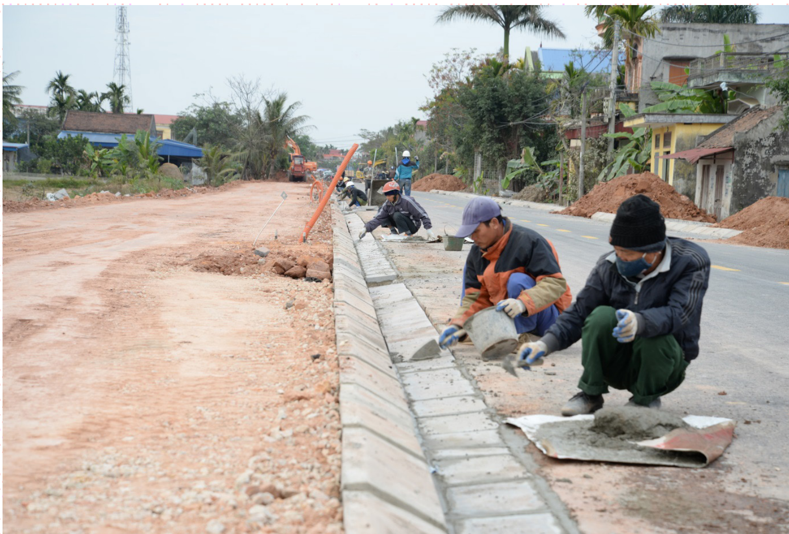
Công trình nâng cấp, cải tạo đường trực từ Ủy ban nhân dân xã Kiến Thiết, huyện Tiên Lãng tại thôn Nam Tử 1 đến Ngã tư thôn Trì Hào- thôn Thạch Hào
